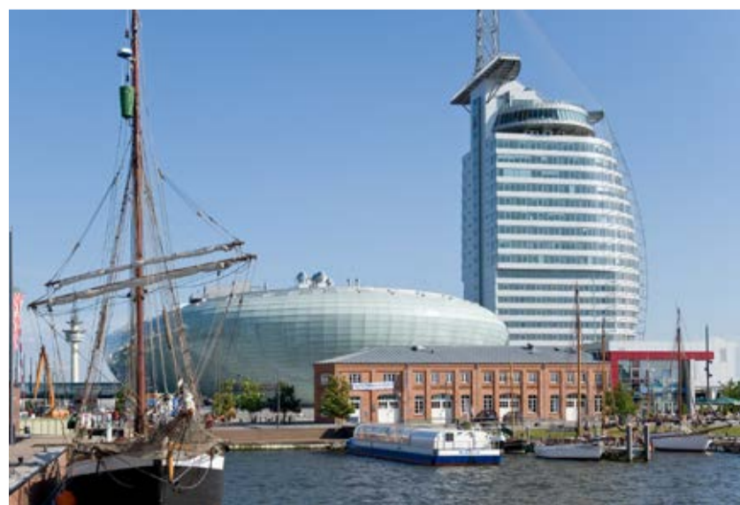
Imposantes Gebilde: Das Klimahaus Bremerhaven ist von außen wie innen einen Blick wert. Foto: Jan Rathke, Klimahaus Bremerhaven
